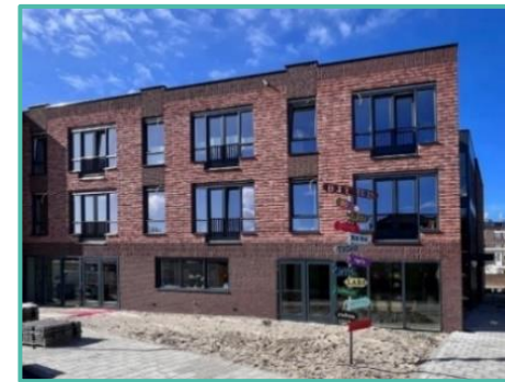
Demo site 3: Droom je Thuis Foundation
