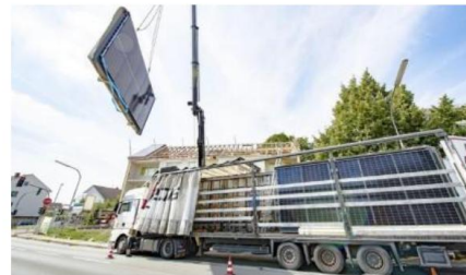
Quelle: Tamara Pribaten/dena
